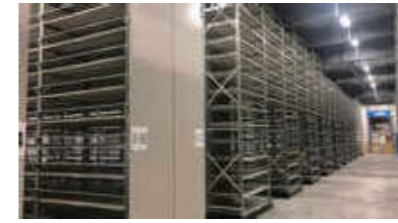
高耐食性メッキ鋼板を採用した物流倉庫
